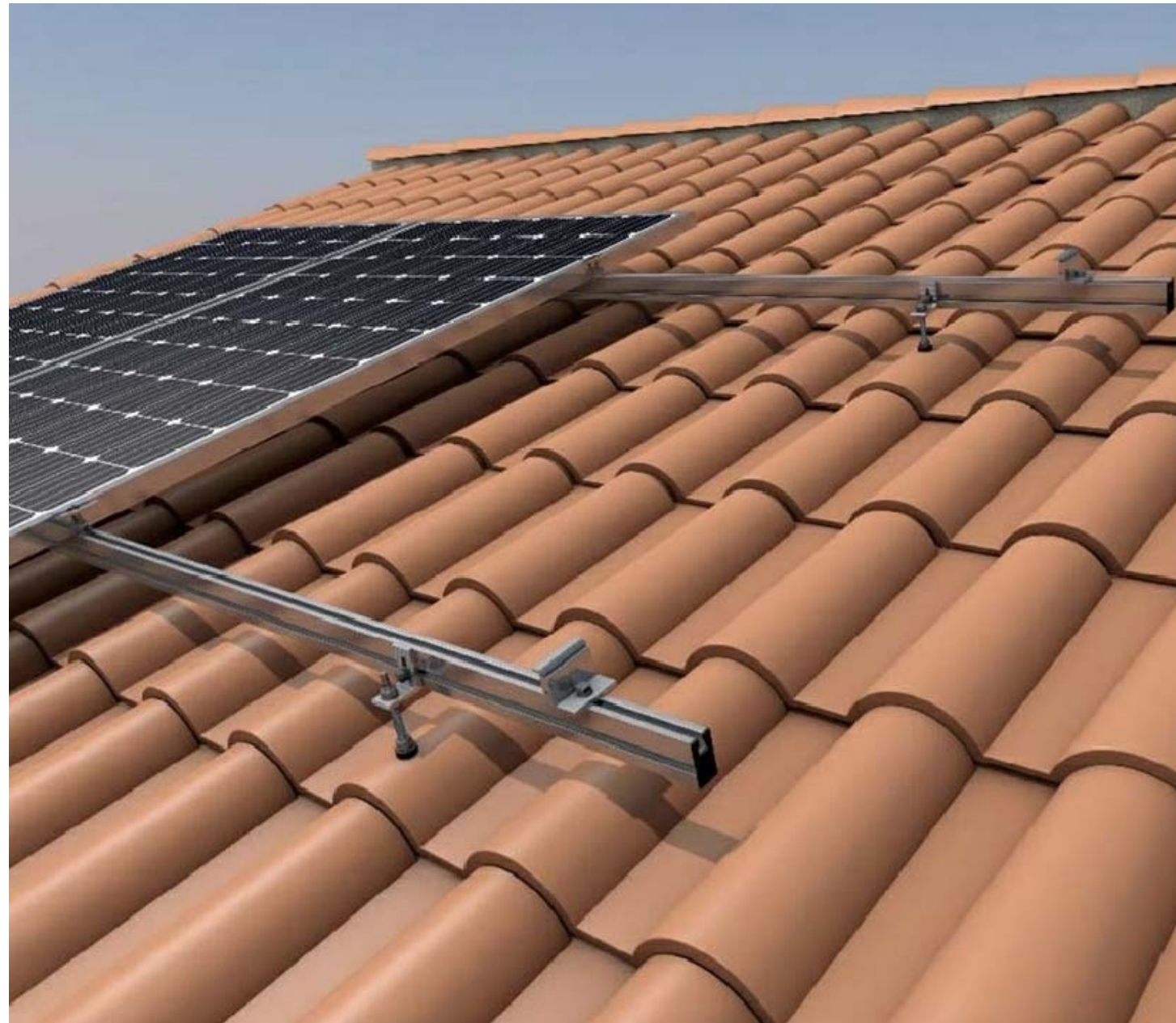
DETALLE ESTRUCTURA EN CUBIERTA DE TEJA
